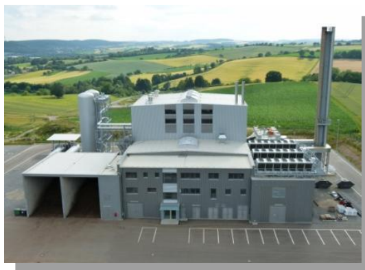
Abb. 1 Biomasseheizkraftwerk. Quelle: www.avr-rnk.de
