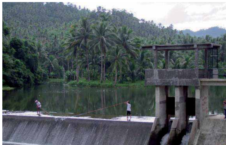
Runoff Messungen im Einzugsgebiet
