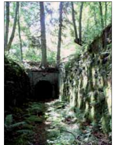
Alter, von Farnen überwachsener Stolleneingang
