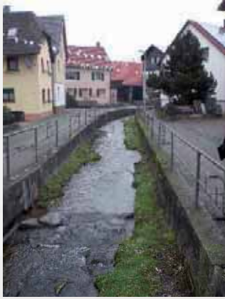
Strukturverbesserungsmaßnahmen an der Oos. Um den sich absetzenden Schlack und Hochwasser entgegenzuwirken, wurden Störsteine eingebracht. Außerdem wurde das Bachufer bepflanzt. Der Bachlauf ähnelt nun wieder seinem natürlichen Lauf. Quelle: Valentin Gauß.
