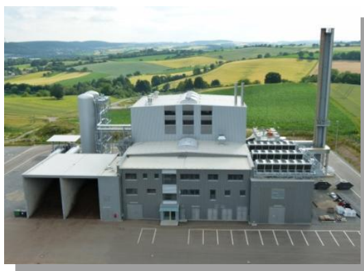
Abb. 1 Biomasseheizkraftwerk. Quelle: www.avr-rnk.de
