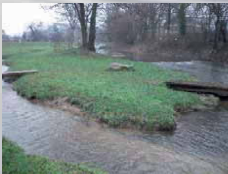
Die Revitalisierungsmaßnahmen an der Oos. Durch Störsteine und Retentionsflächen wird versucht, einem Hochwasser entgegenzuwirken. Außerdem wurde auf den Retentionsflächen ein Erlebnispfad errichtet. Stege und eine kleine Insel im Fluss laden im Sommer zum Baden und Plantschen ein und fanden großen Zuspruch in der Bevölkerung. Quelle: Valentin Gauß.
