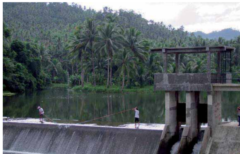
Runoff Messungen im Einzugsgebiet
