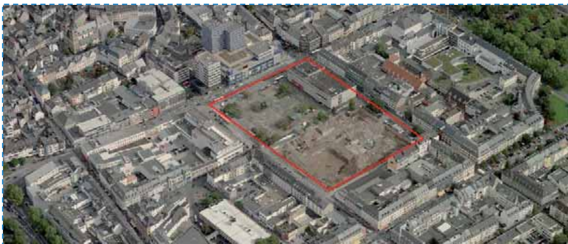
Abb.2 : Brachfläche in Zentral-Koblenz; Zukünftiger Kultur- und Wirtschaftsmagnet. Quelle: http://i55.tinypic.com/8x54c7.jpg (06.12..2010)
